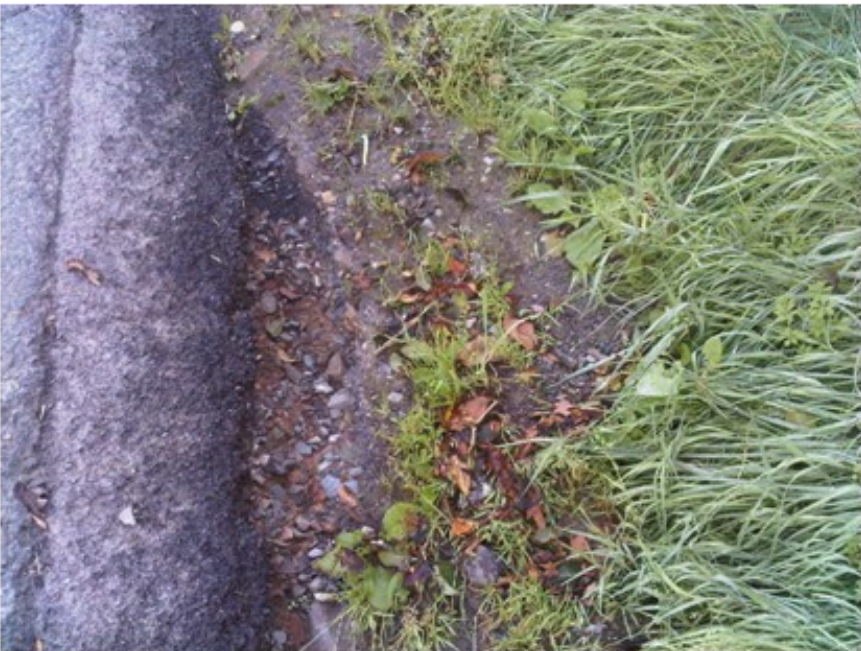
Ravine de 30 cm de profondeur entre bande roulement de la route et fossé bouché
