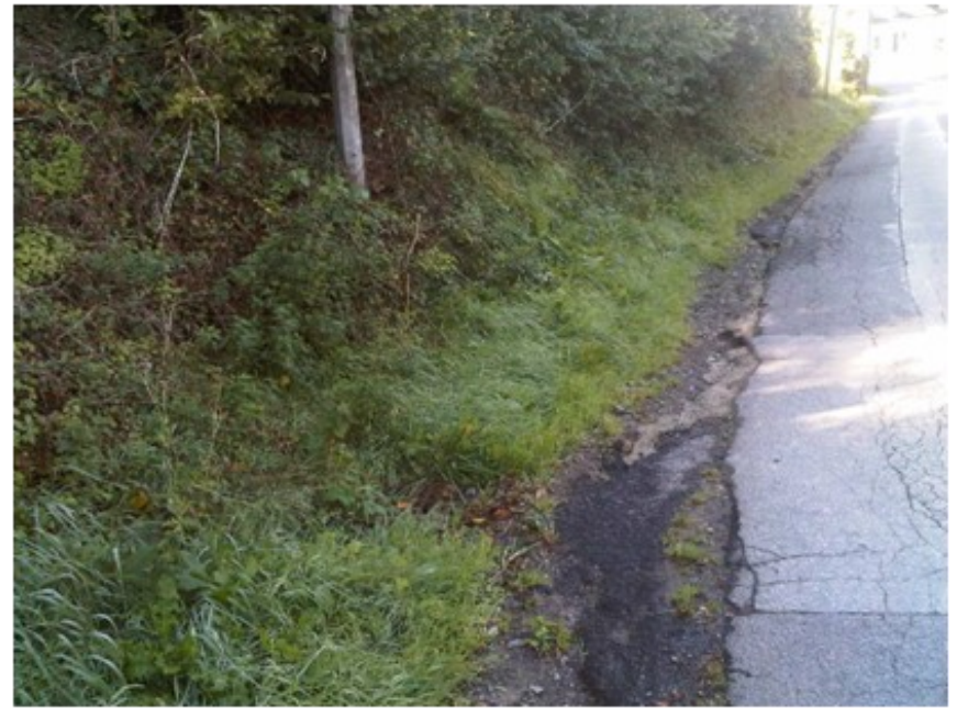
Ravine de 30 cm de profondeur entre bande roulement de la route et fossé bouché
